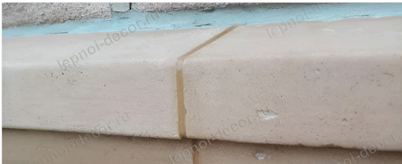
ФОТО • Загерметизированный шов между элементами
