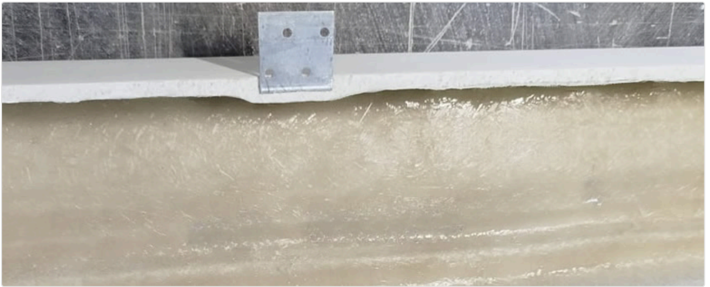
ФОТО • Усиленная зона для крепления кронштейна или уголка
